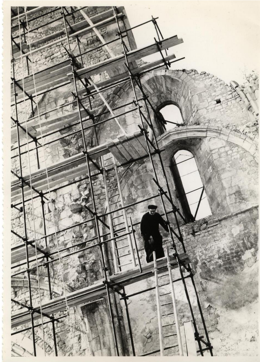
Paul Verrier dans les ruines de l'église de Gy-l'Evêque lors des travaux de consolidation du clocher en 1956
